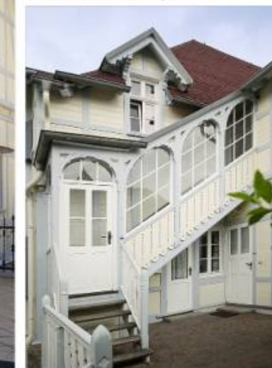
Der Treppenaufgang des Wolgasthauses wurde nachträglich verglast und weiß getüncht. Er wirkt hell und luftig.
