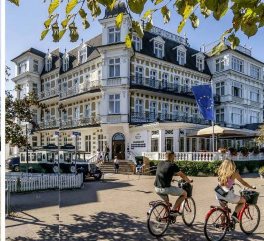
Im Hotel Ahlbecker Hof von 1890 sind innen und außen viele historische Elemente erhalten.
